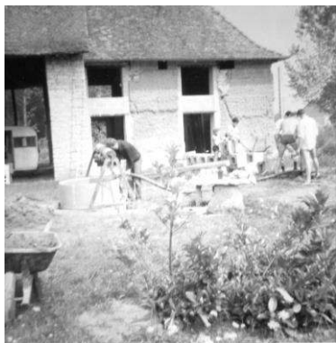
Construction du puits
